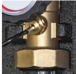
Tauchhülse für Temperaturfühler im Vorlauf
